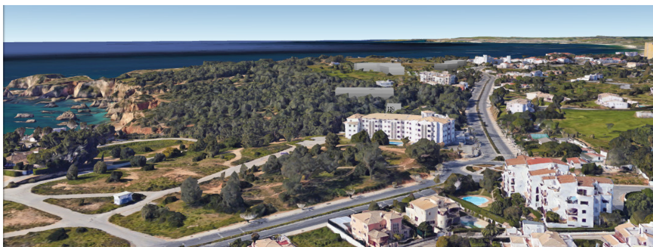
Vista Nascente Poente das edificações hoteleiras H1, H2 e H3
