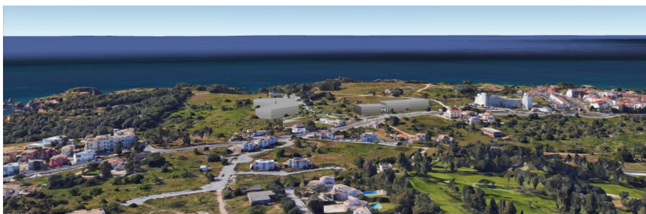
Vista Norte – Sul das edificações hoteleiras H1 e H2
