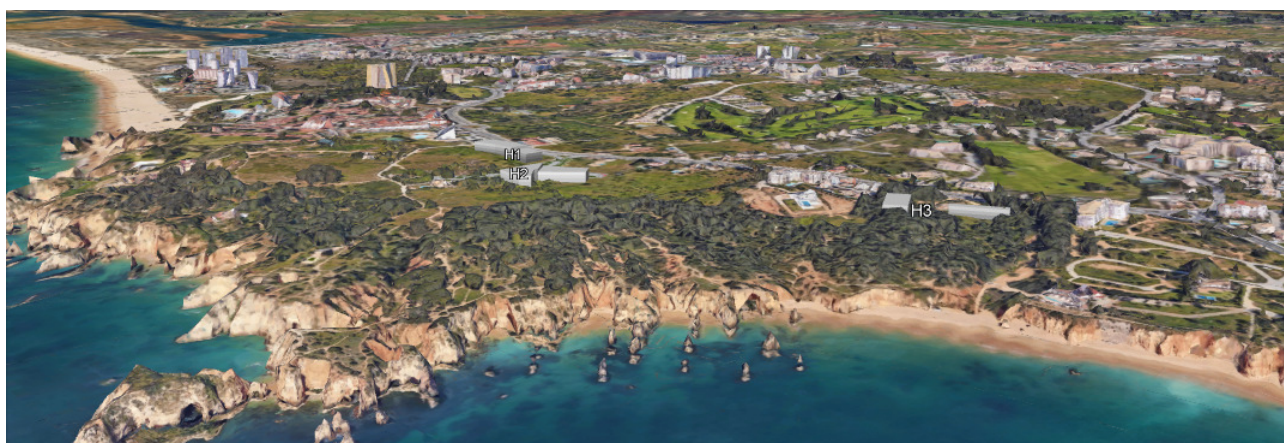
Vista SE-NW das três edificações H1, H2 e H3
