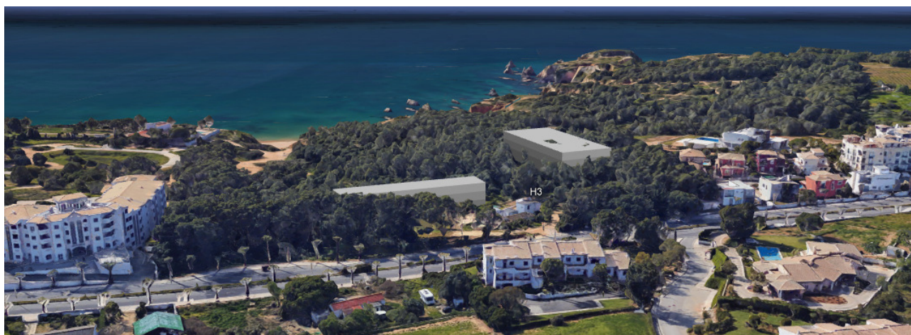
Vista Norte Sul da edificação H3
