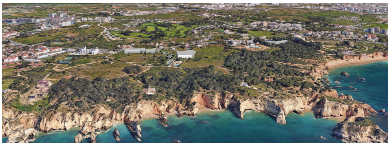
Vista SW-NE das três edificações H1, H2 e H3
