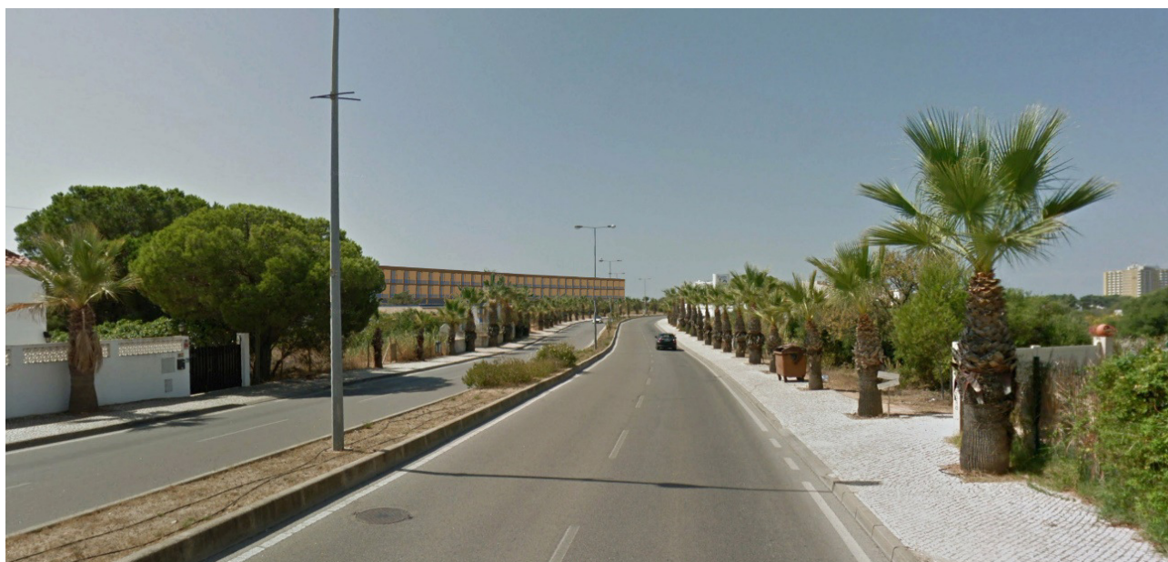
Vista da edificação hoteleira o H1 antes e depois de construção, a partir da via pública M531
